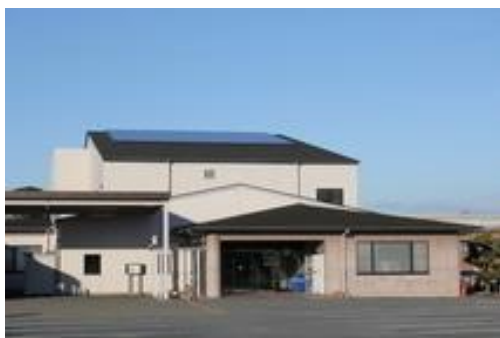
図 2-4 太陽光パネルの様子 （保健福祉会館）
