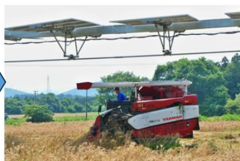
図 7-2 ノータスソーラー・ジャパンが提供する追尾型架台の様子
