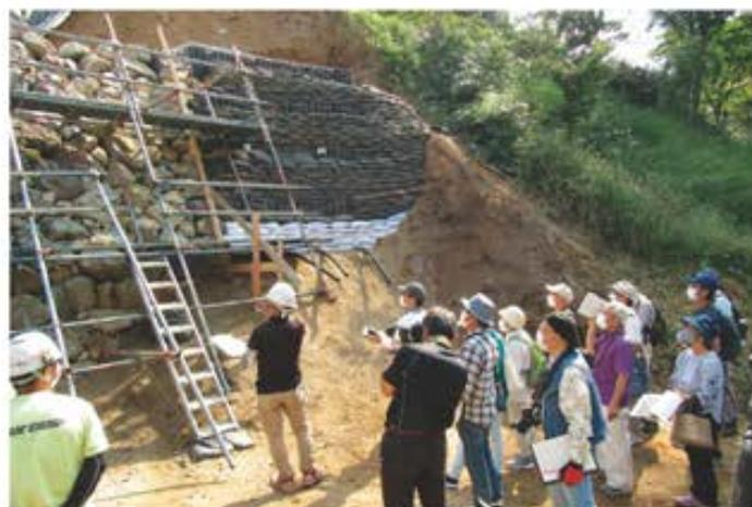
現在、田丸城跡の石垣修復工事を行っている現場で、現地説明会を開催しました。この工事は、平成29年10月の台風で崩落した石垣のひとつを積み直すものです。
