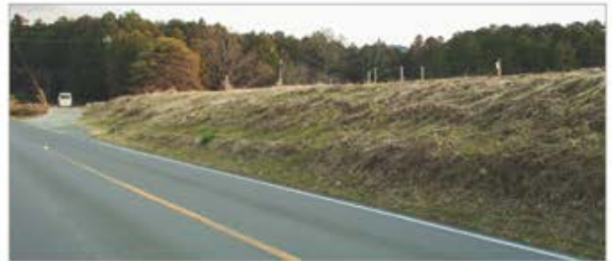
勝田大池漏水対策工事
