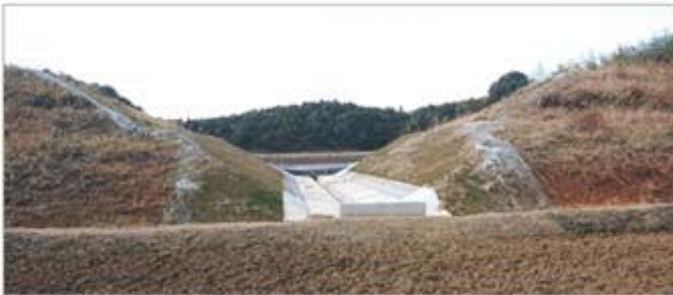
まちなのわだい 大山田池廃止工事(上田辺)
