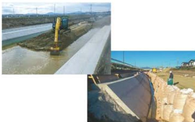
平成29年10月の台風第21号では記録的な大雨により外城田川が越水し、田丸地区を中心に甚大な被害が発生しました。町では安全で安心して暮らせる環境整備として、令和2年度から外城田川の河川断面を広げる工事を実施しています。なお、工事については引続き次年度も実施する予定です。工事期間中は、大変ご迷惑をお掛けしますが、ご理解とご協力をお願いします。
