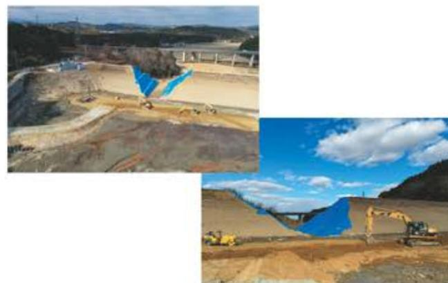
大規模地震や大雨による堤体の決壊を防ぐため、玉城町原にある「原新池」の改修工事が行われています。
